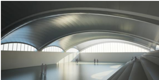
Doppelt-gekrümmte Dachkonstruktion aus Sandwichelementen – © KGBauko
